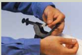
Insertión de la Fibra en el Conector
